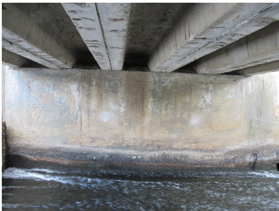
Obrázek 2: uložení mostu na nábrežních zdech
